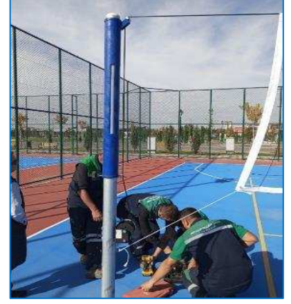
Spor Sahası EPDM Zemin Tamirati
