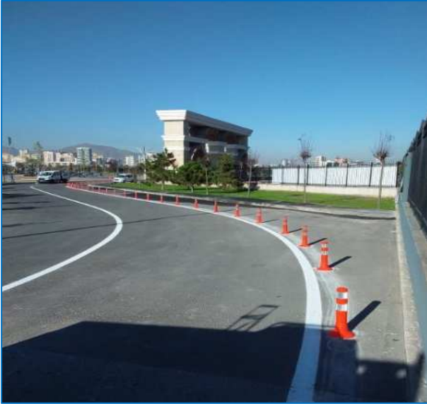
Delinatör Montajı
