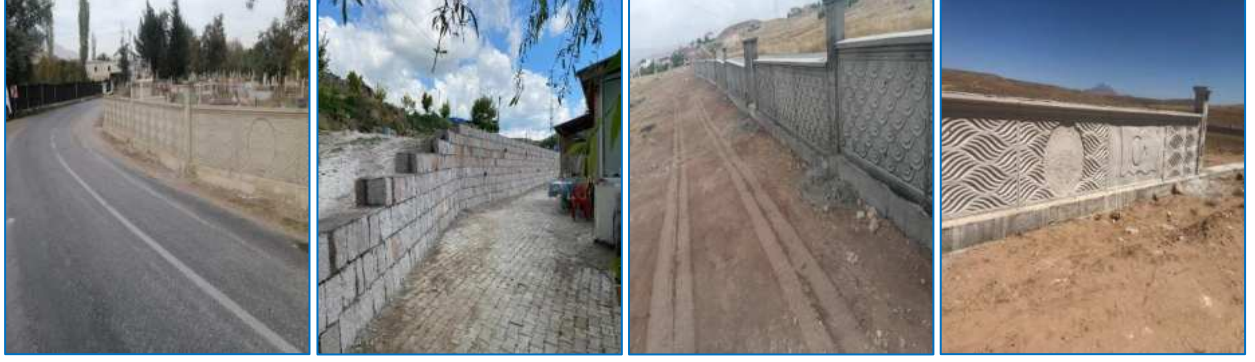
Sosyal Tesisi Yapım, Bakım ve Onarım
