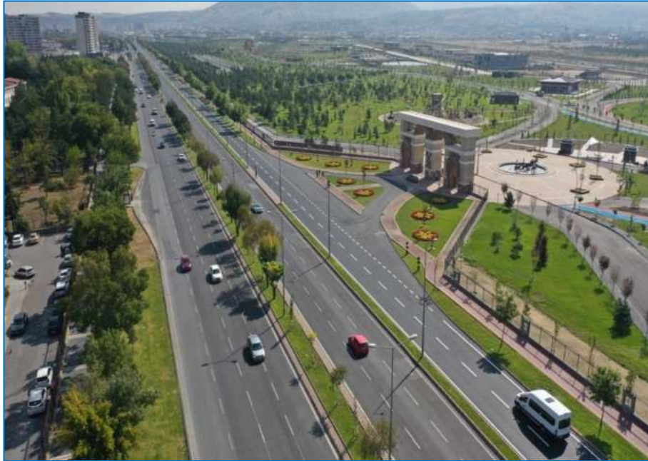
Talas Bulvarı Transit Yol Asfalt Yenileme Çalışmaları
