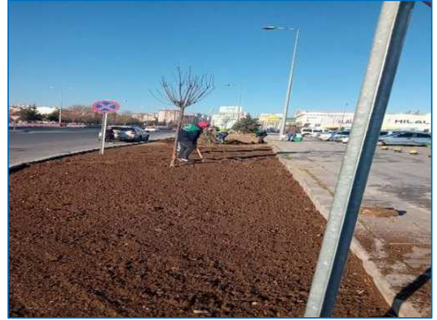
Terminal Önü Çim Ekim ve Tesviye Çalışması
