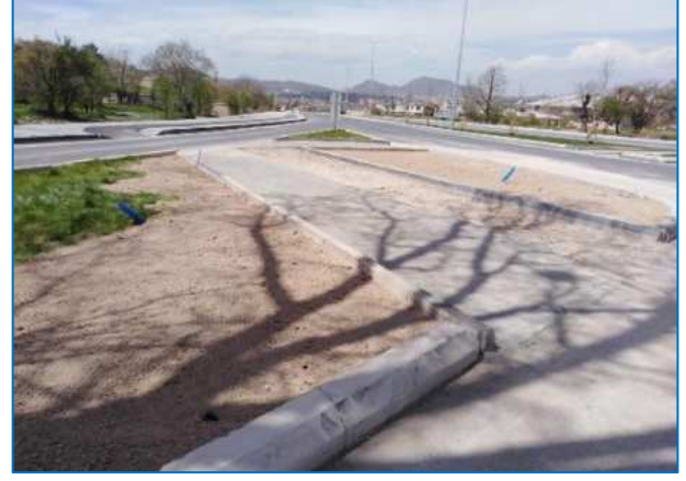
Erenköy Mah. Yaya Geçitler Toprak Dolgu ve Tesviye Çalışması
