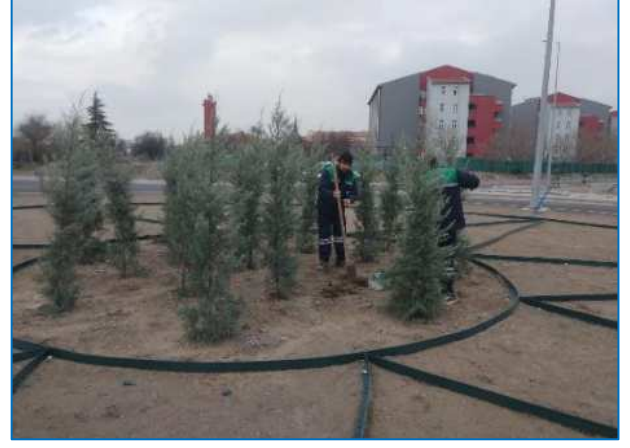
Doğu Sanayi Orta Refüj Tesviye ve Peyzaj Çalışması
