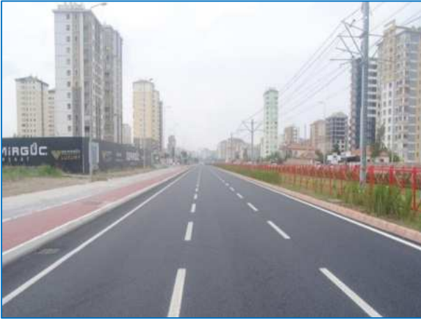
Hulusi Akar Bulvarı Asfalt Yenileme Çalışmaları
