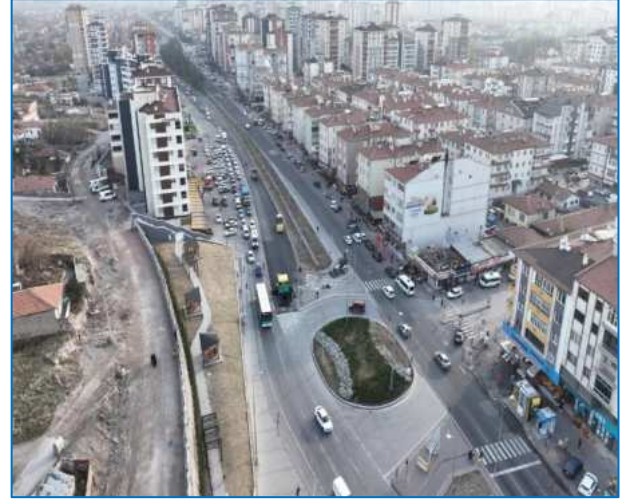
Erkilet Bulvarı Asfalt Yenileme Çalışmaları
