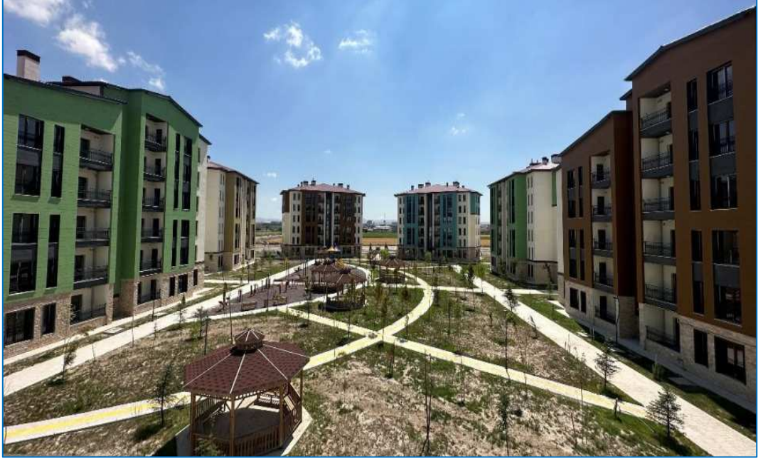
Kentsel Dönüşüm ve Gelişim Proje Alanı 1. Etap Biten Bloklar
