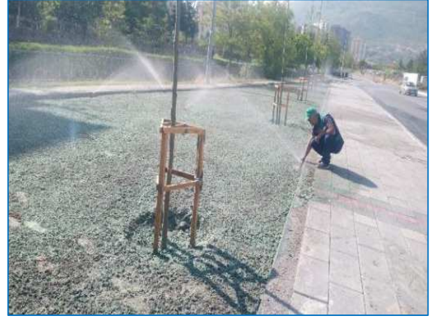
Talas Kız Yurdu Arkası Yan Bant Püskürtme Çim Uygulaması
