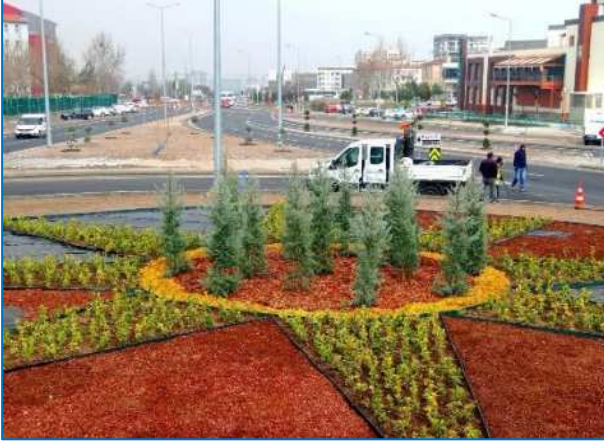
Doğu Sanayi Orta Refüj Tesviye ve Peyzaj Çalışması
