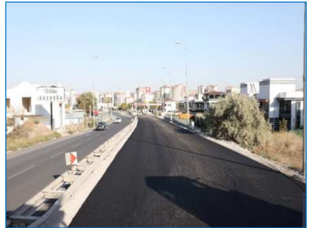
Fatih Sultan Mehmet Bulvarı Asfalt Yenileme Çalışmaları
