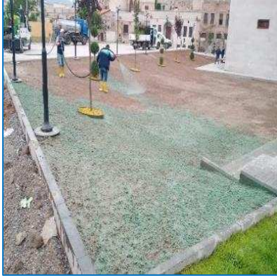
Kayseri Mah. Tesviye Peyzaj ve Çim Püskürtme Uygulaması
