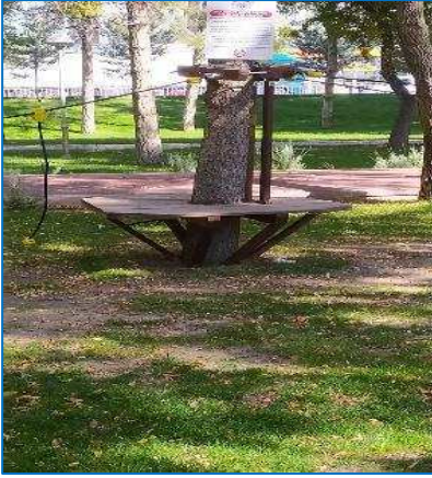
Macera Parkuru Bakım Onarımı
