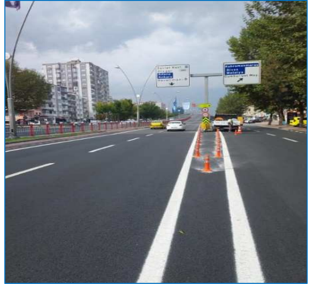
Delinatör Montajı
