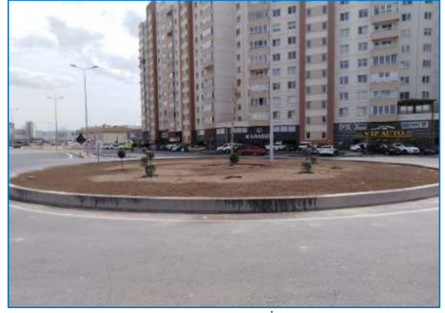
Galericiler Sitesi Göbek Orta Refüj İnce Tesviye Çalışması
