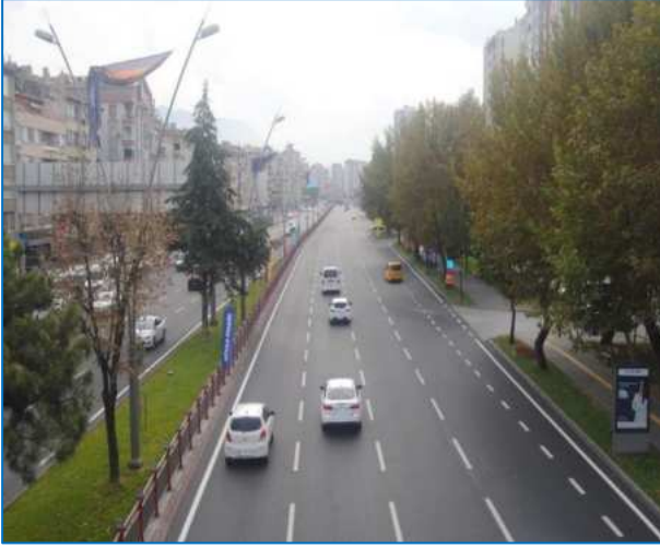
Mustafa Kemal Paşa Bulvarı Asfalt Yenileme Çalışmaları
