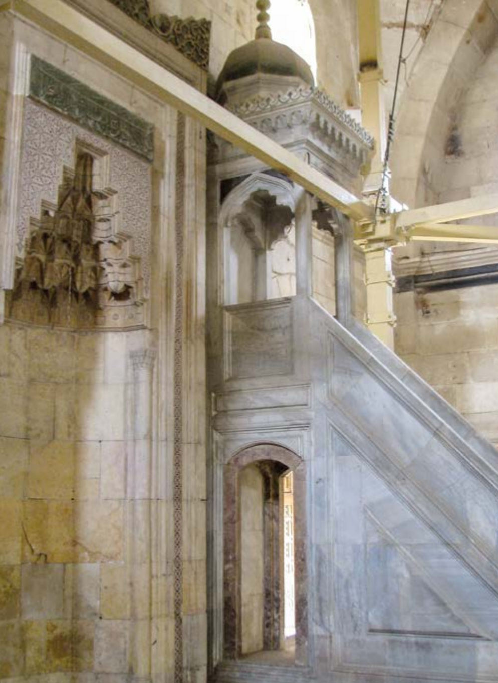
▲ Süleymaniye Camii restorasyon halinde - 2009
