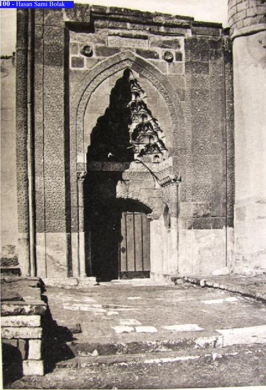
I - PORTAIL DE LA MOSQUÉE DE HADJİ KİLİDİ.
