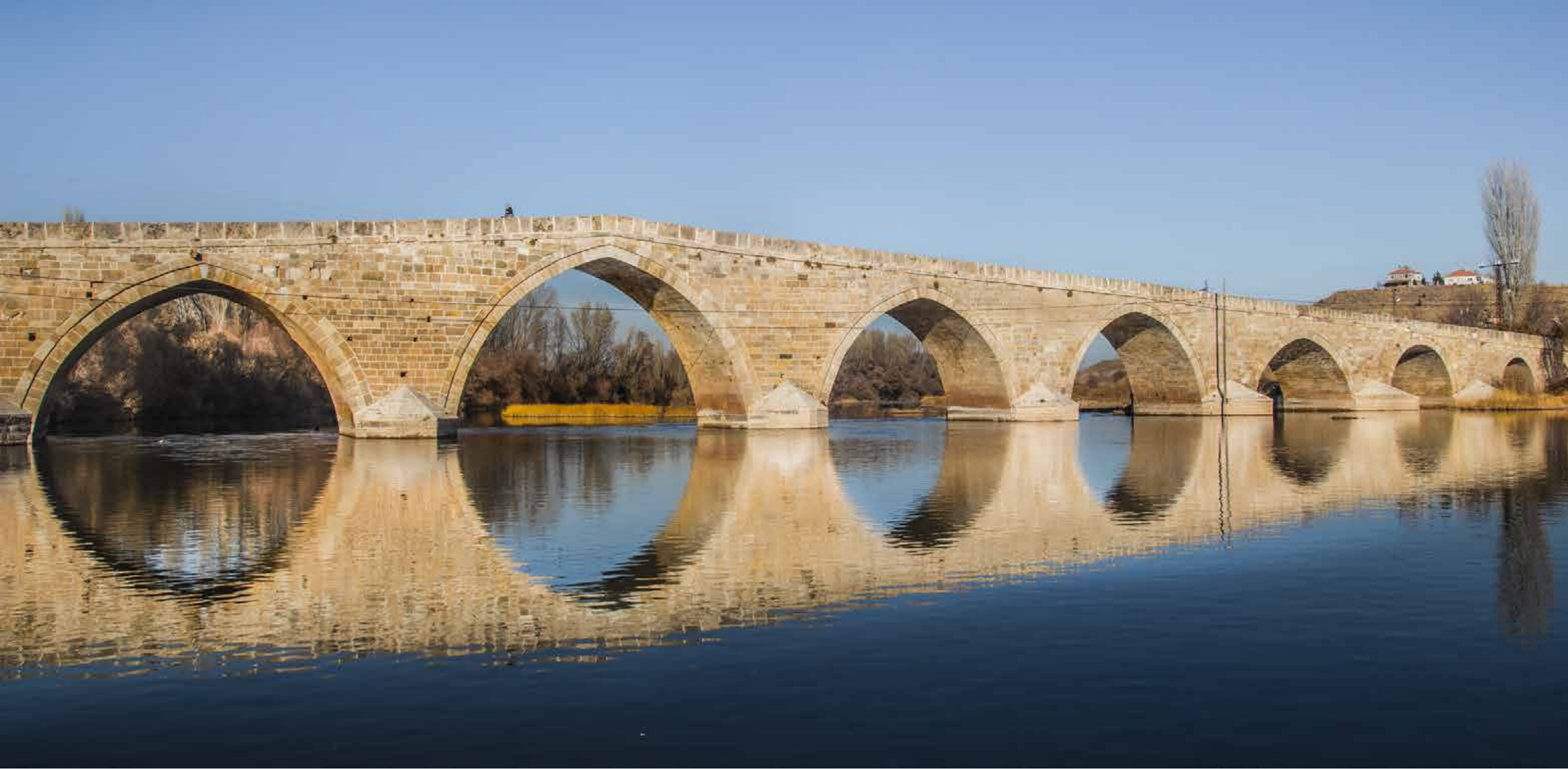
Selim ALTINDİŞ ŞAHRUH KÖPRÜSÜ / SAHRUH BRIDGE
