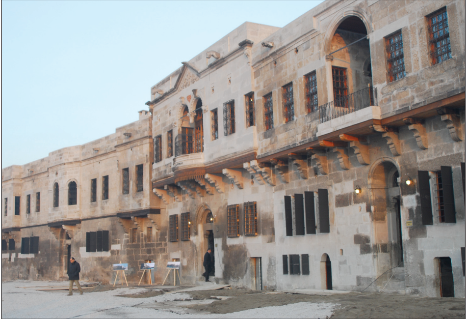
Restorasyonu tamamlanan eski Kayseri evleri
