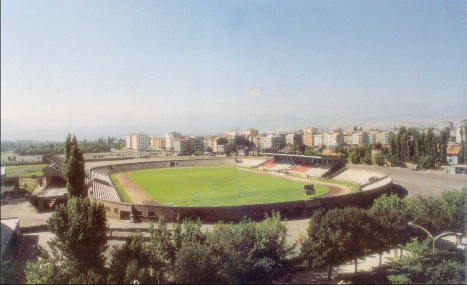
Eski Atatürk Stadyumu-ilave tribünler inşaa halinde
