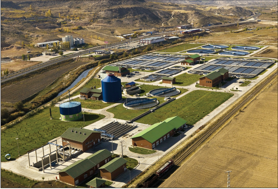
Kayseri Atıksu Arıtma Tesisi
