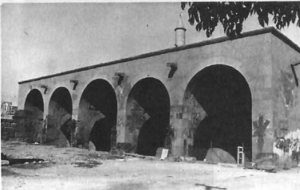
Han Camii revakı
