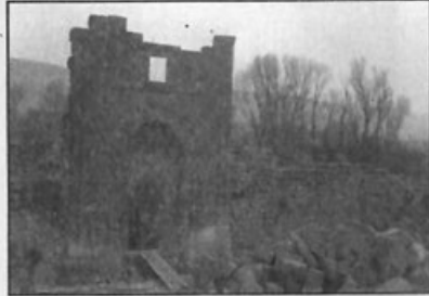
Taşkın Paşa Medresesi (Zaviyesi) onarımdan önce
