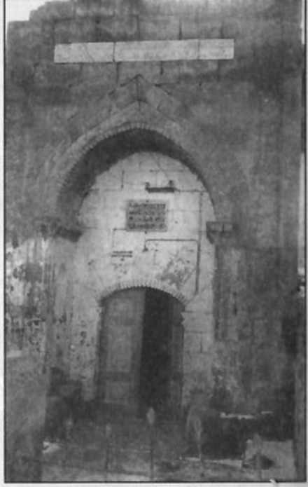
Develi Ulu Camii Kapısı
