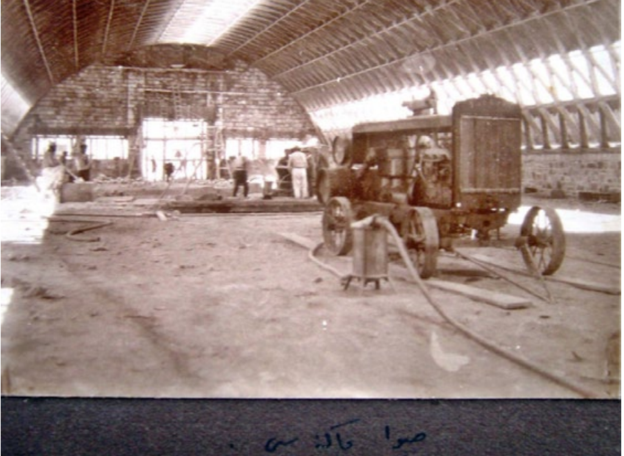
Fotoğraf 68: Uçak Fabrikası Hangar İnşaatında Sıva Makinesi
