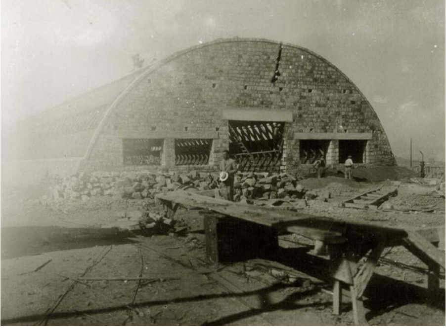
Fotoğraf 77: Hangarların İnşası
