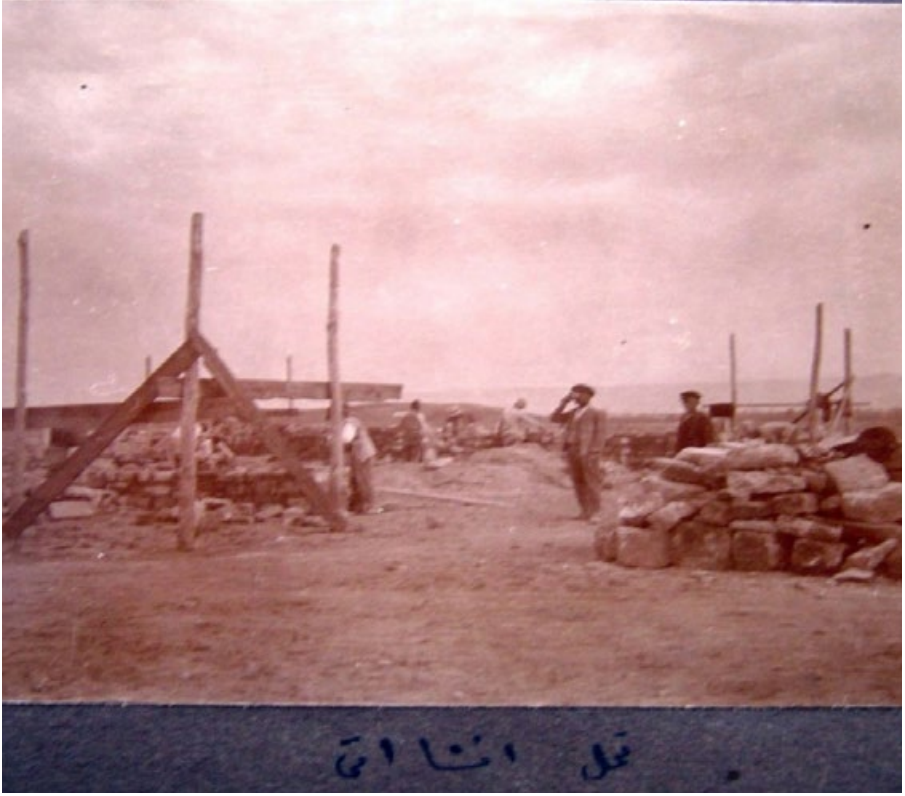
Fotoğraf 31: Temel İnşaatı 420
