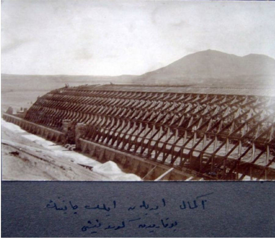
Fotoğraf 34: İnşaatı Tamamlanan İlk Çatının Görünüşü 437
