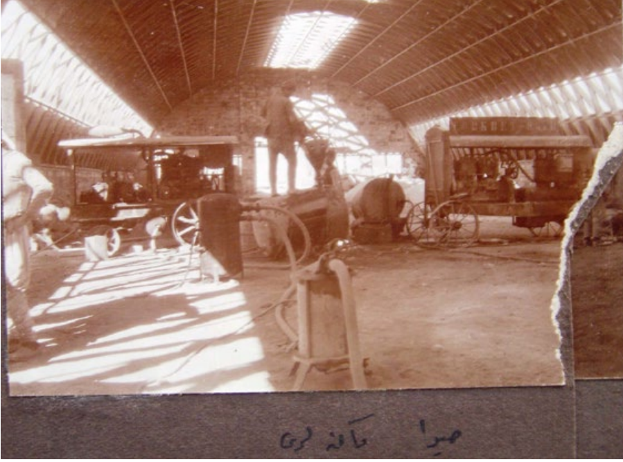
Fotoğraf 73: Hangarların İnşası
